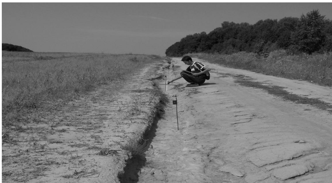
Рис. 3. Ерозійні розмиви на ґрунтовій дорозі поблизу села Гірники (світлина І. Ковальчука)
