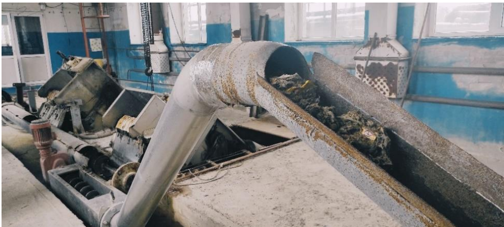
Рис. 18.1. Механічне очищення: затримані на ґратах предмети із стічних вод
