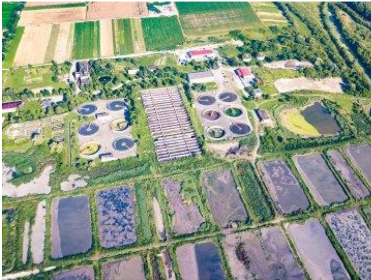
Рис. 18.2. Очисні споруди каналізації КП «Луцькводоканал» (с. Липляни Луцького району) з висоти пташиного польоту
