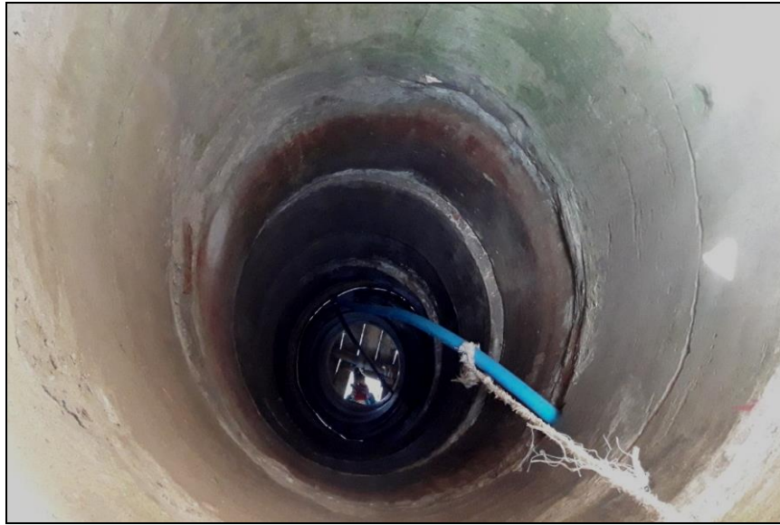
Рис. 2.2. Колодязь вул. Покрупівка, 3
