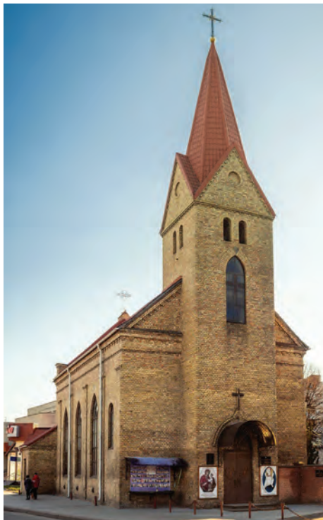
Рис. 178. Лютеранська кірха з будинком причту у Володимирі. Побудована наприкінці XIX ст. Сучасний вигляд
