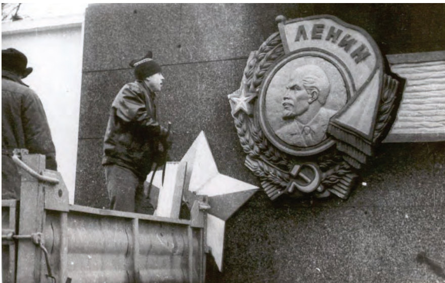
Рис. 327. Демонтаж дошки Героїв Соціалістичної Праці в Луцьку
