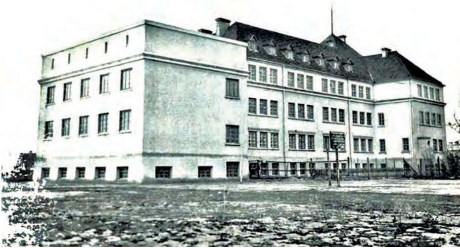
Рис. 186. Купецька гімназія, приміщення «Польської матері шкільної» (нині тут міститься Управління СБУ у Волинській області). Фото 1937–1938 рр.
