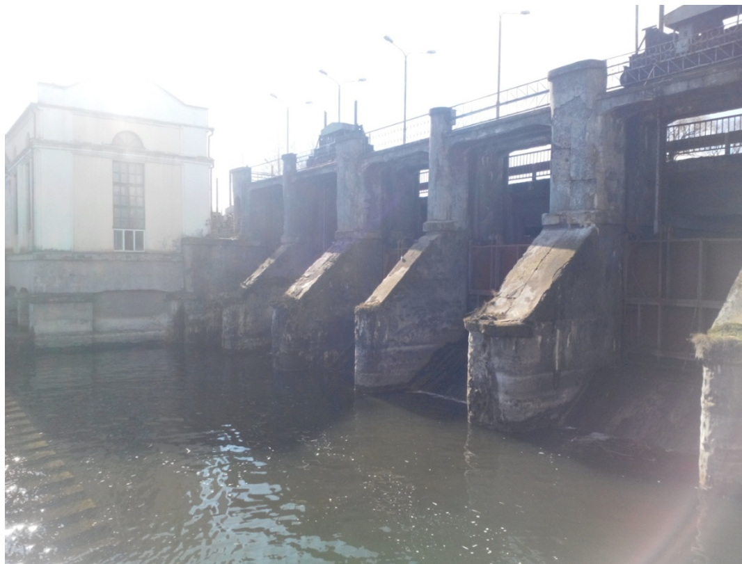
Рис. 2 Мінімально можливий рівень води на Хрінницькій ГЕС (рівень води нижче нижньої межі шлюзів)
