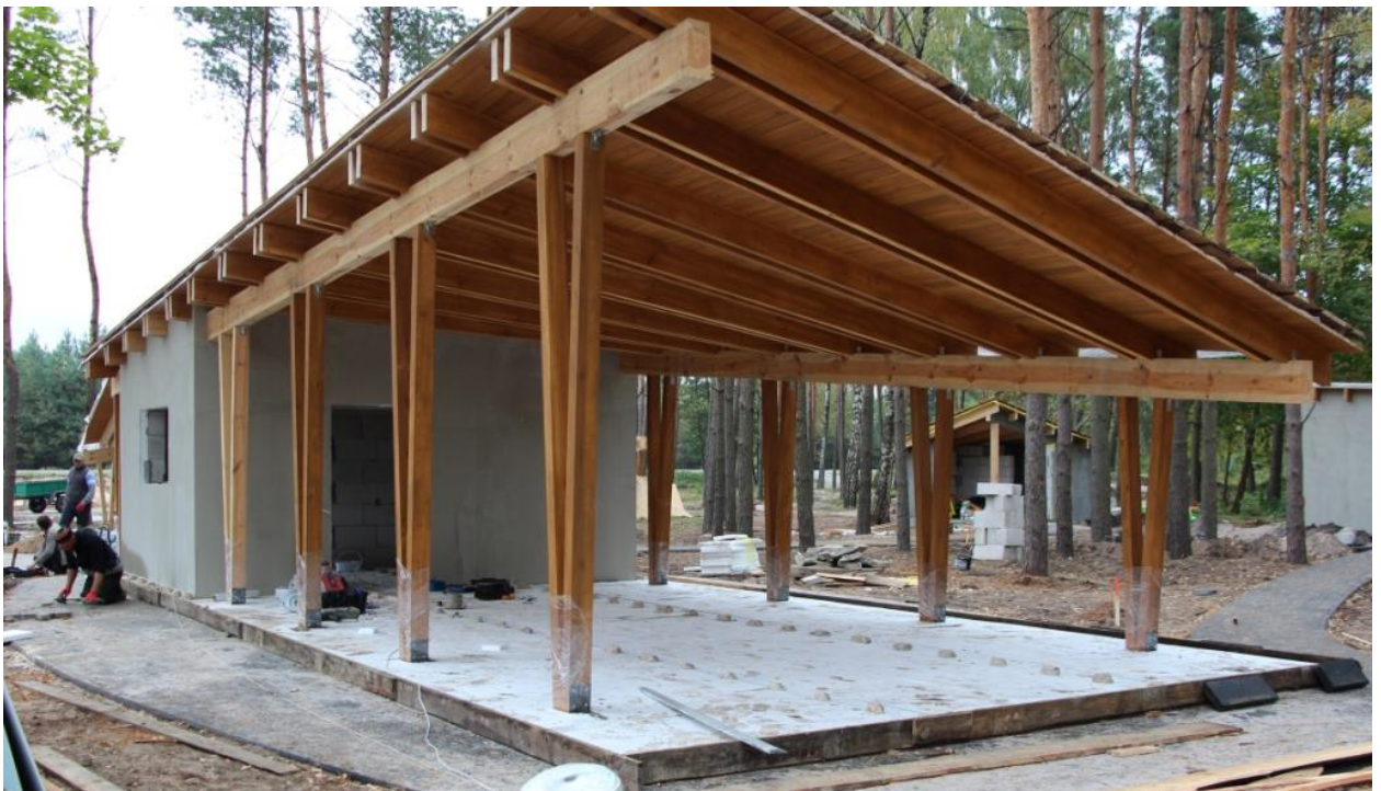
Рис 3.6. Будівництво рекреаційного пункту
