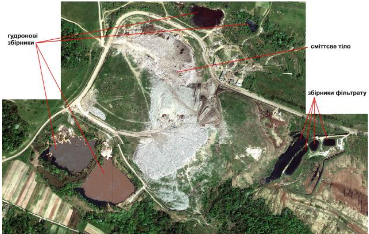
Рис. 1. Просторове розташування сміттєвого тіла, гудронових збірників та збірників фільтрату Львівського полігону ТПВ на космознімку Google Earth
