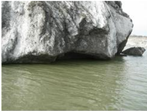
Зародження та поглиблення ніші вилюговування на рівні водного дзеркала в затоплюваному кар'єрі
