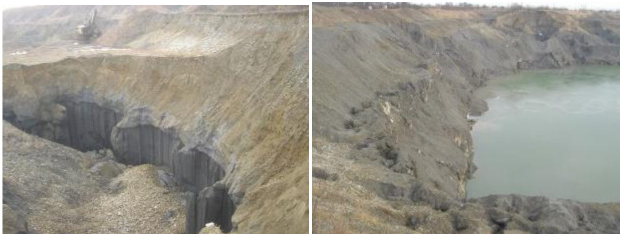
Рис. 4. Руїнування західного (зліва) та північного бортів кар'єру соляним карстом
