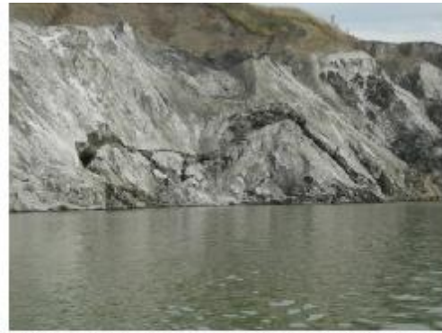
Ерозія, утворення заколів та обвалення борту над нішею вилюговування в затоплюваному кар'єрі
