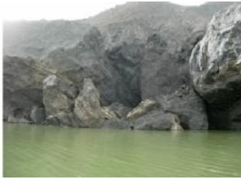
Обвалення бортів, забутовування й самоізоляція солевмісних товщ у затоплюваному кар'єрі
