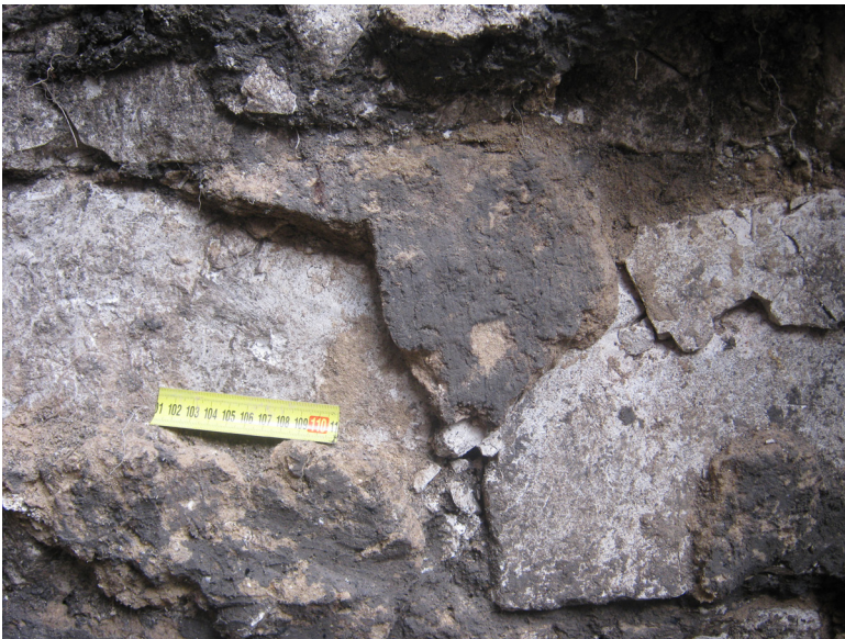
Фото 12. Зонд №2. Затверділий розчин на фундаменті Стіни №1. Вигляд зі сходу.
