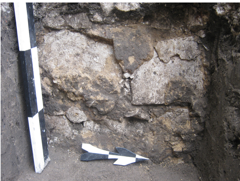
Фото 11. Кладка фундаменту Стіни №1. Вигляд зі сходу.
